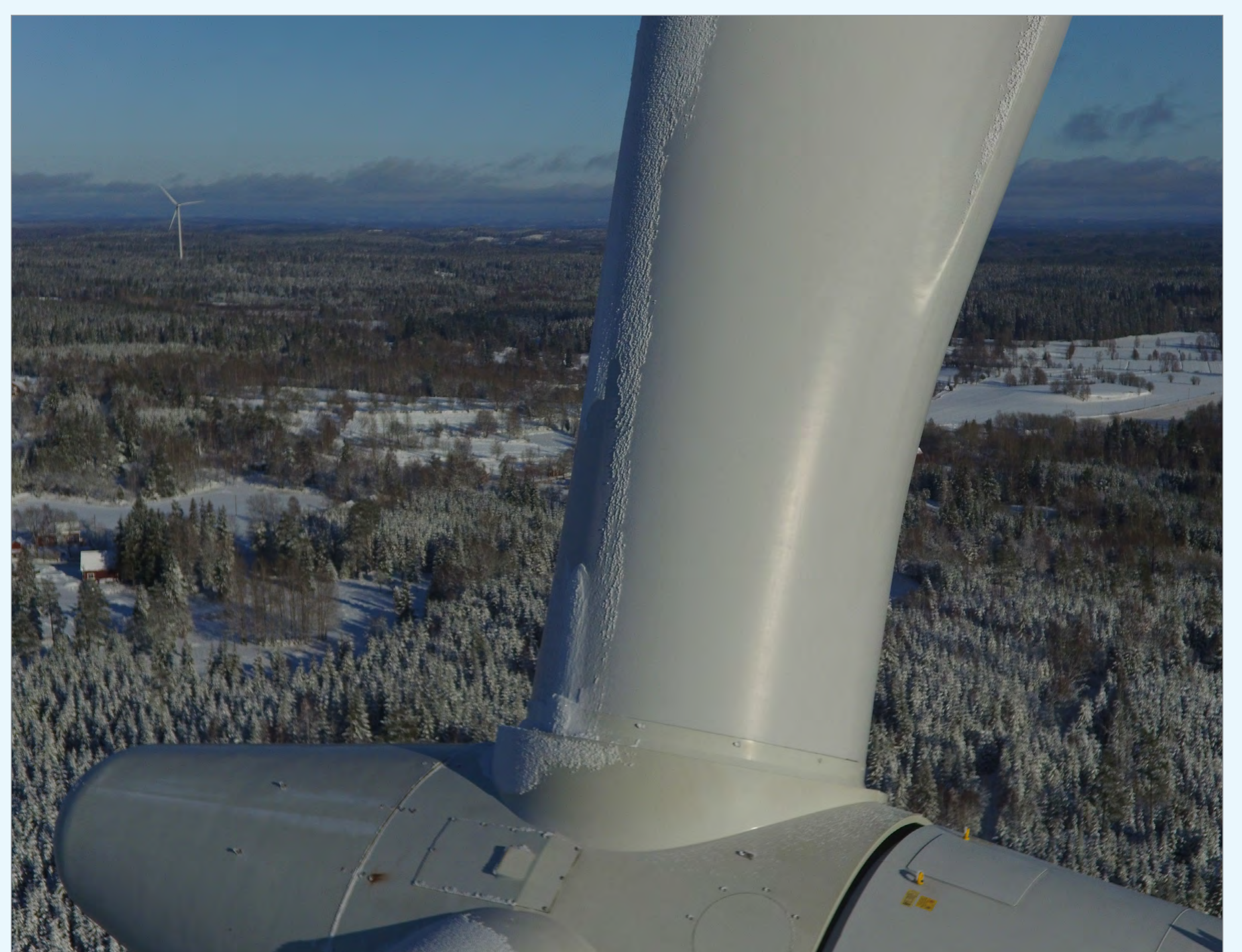
Isbildning på vindkraftverk
