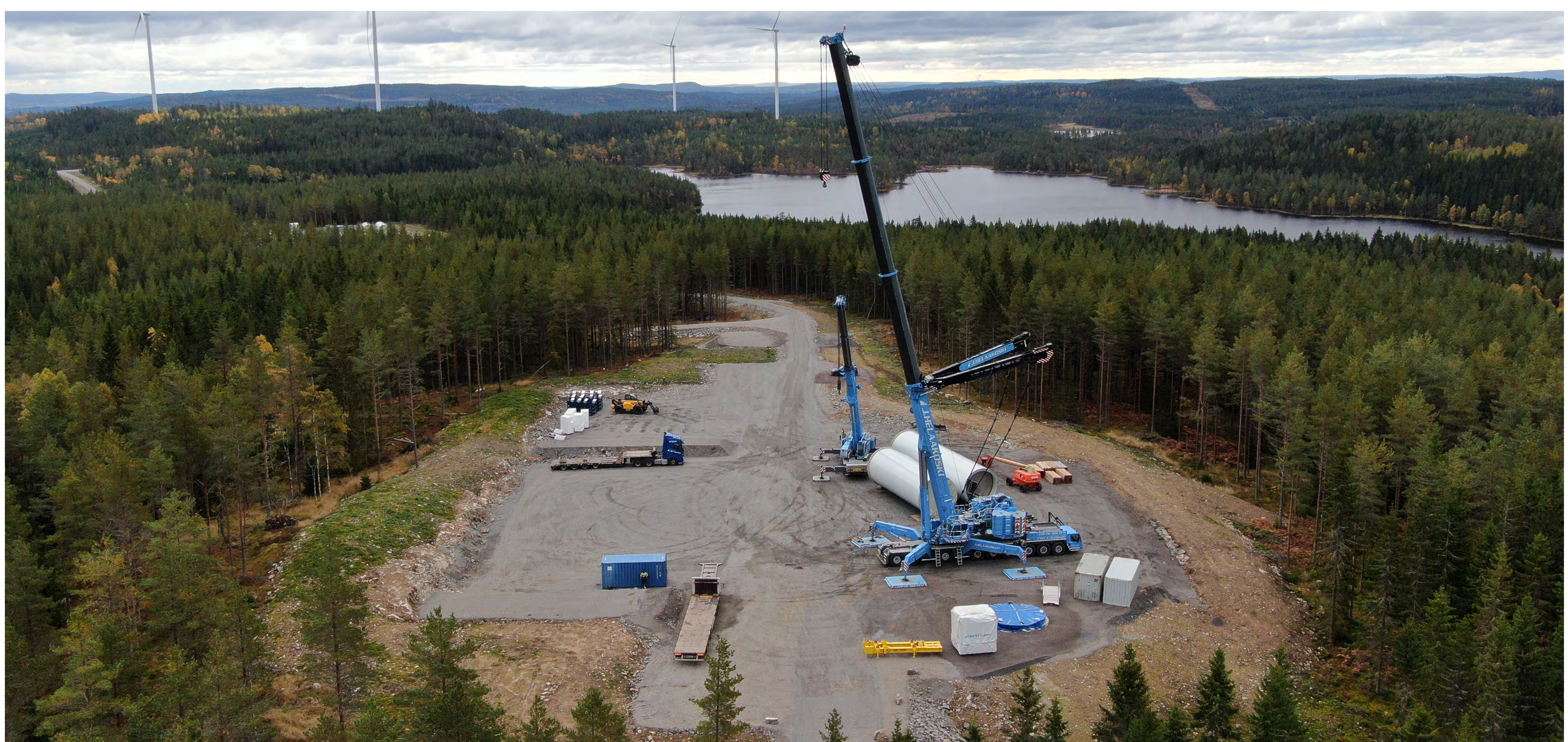
Arbets- och upplagsytor vid ett vindkraftverk
