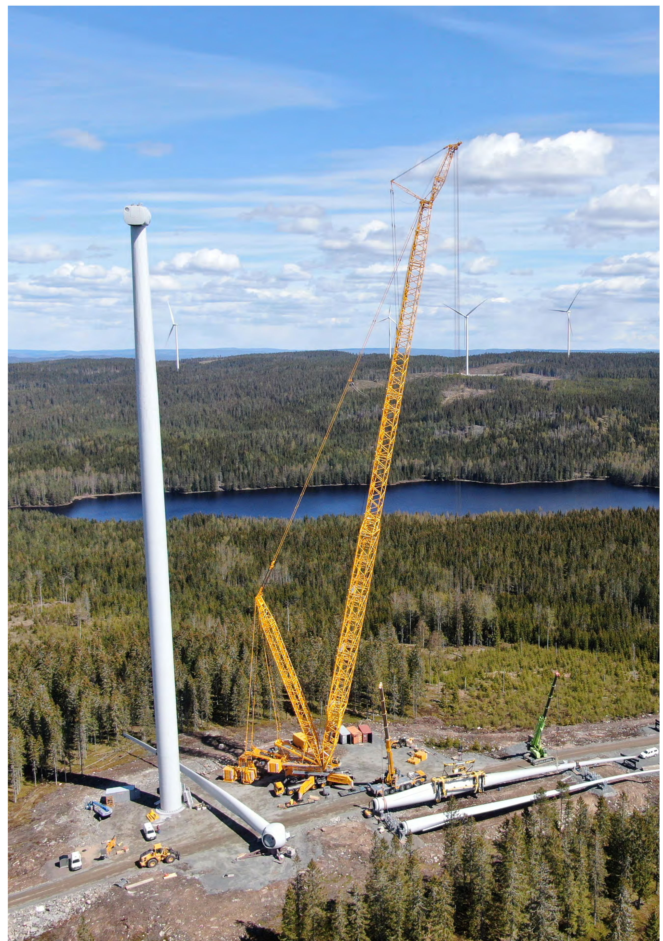
Montering av vindkraftverkets blad
