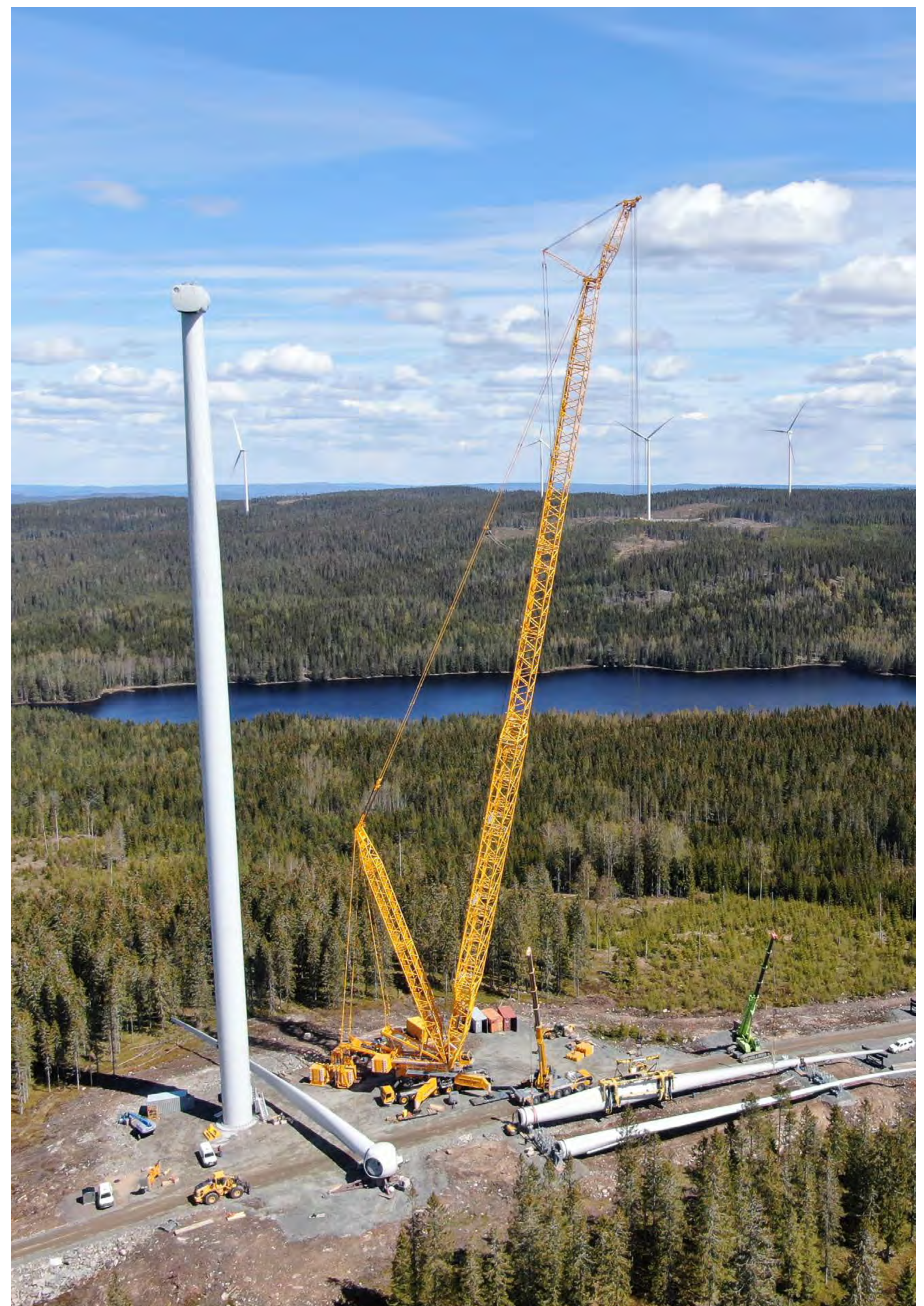
Montering av vindkraftverkets blad
