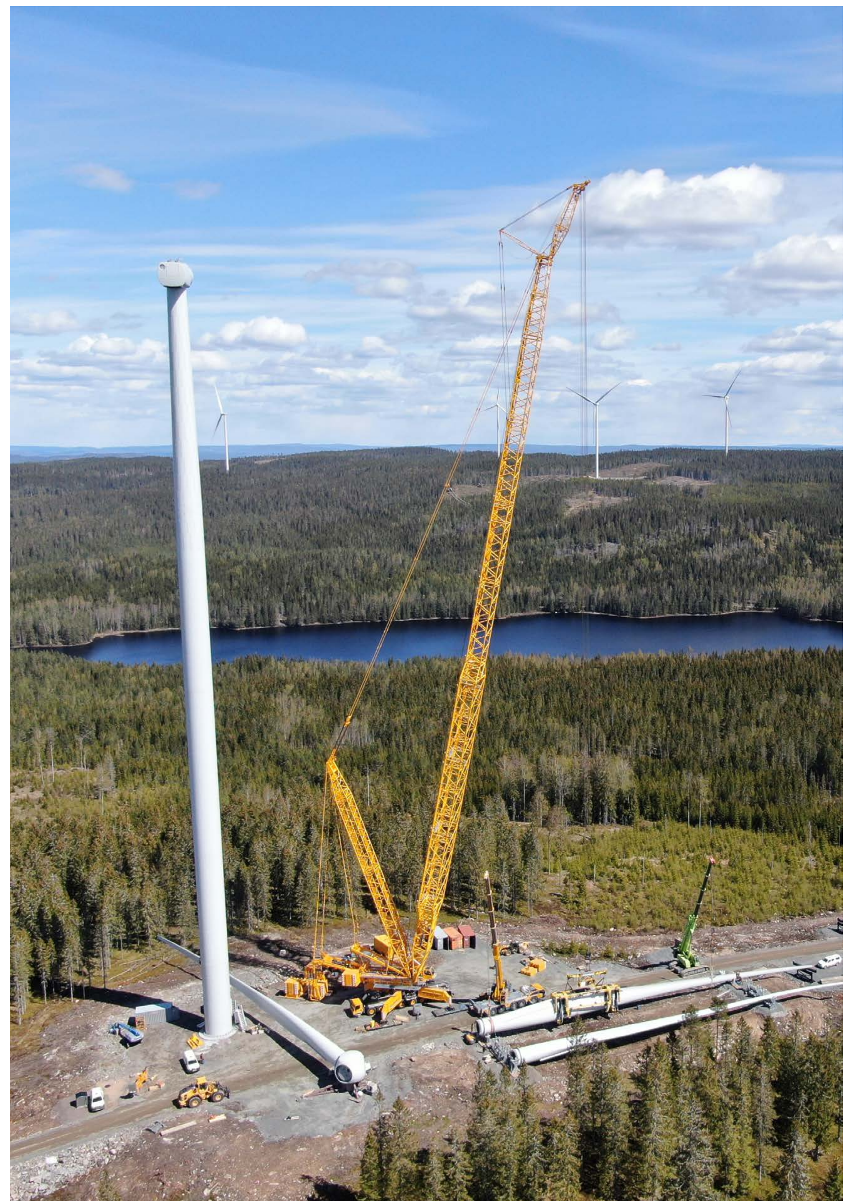
Montering av vindkraftverkets blad
