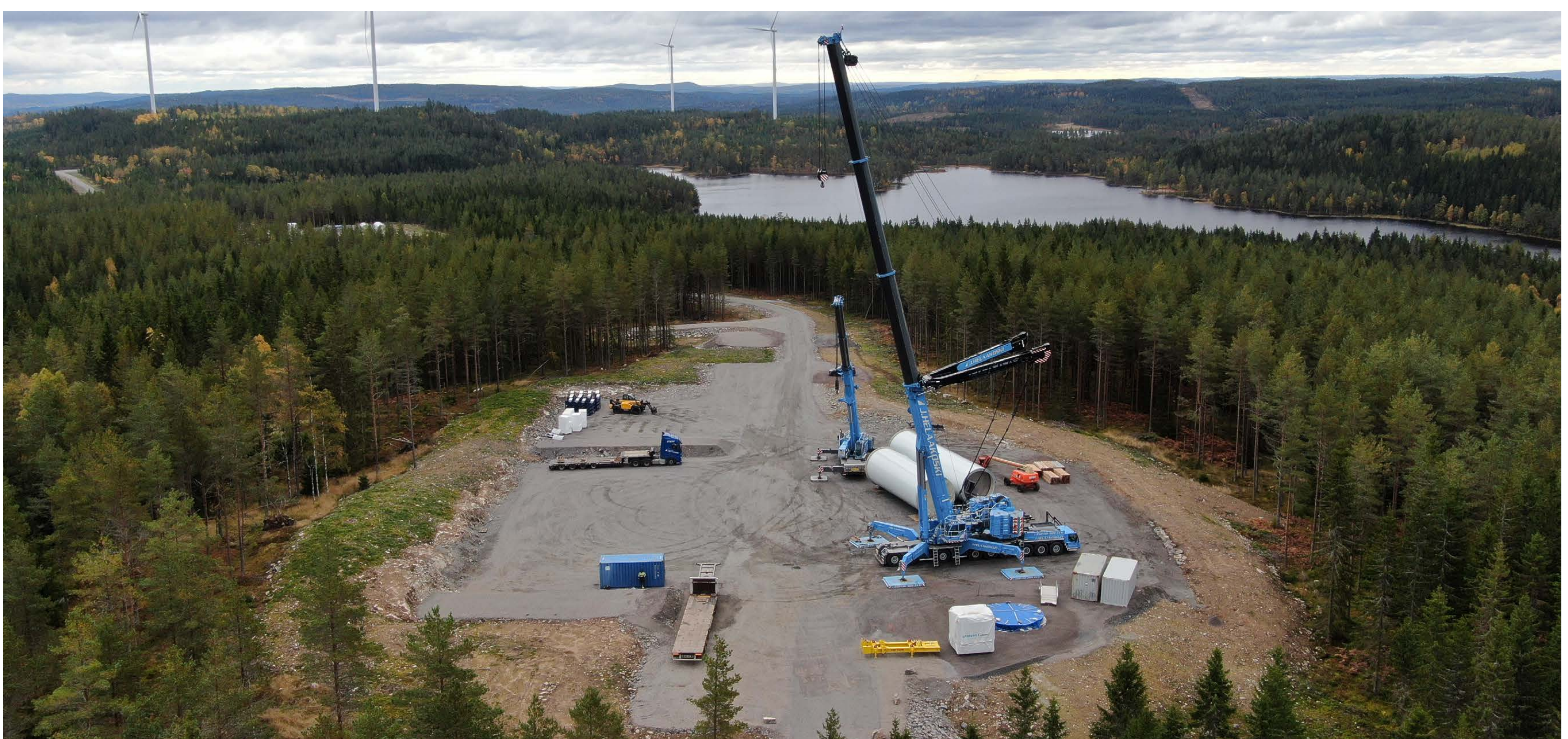
Arbets- och upplagsytor vid ett vindkraftverk
