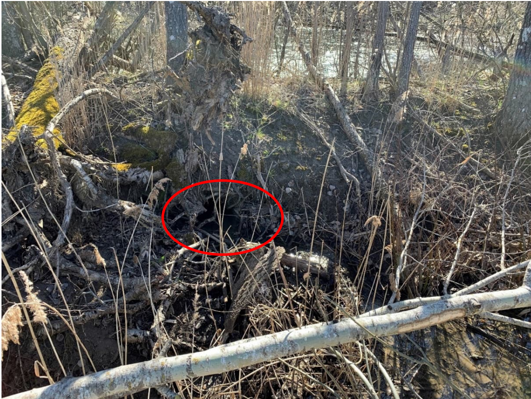
Foto 8 – Anm 5. Kavitet i fyllnadsdamm.
