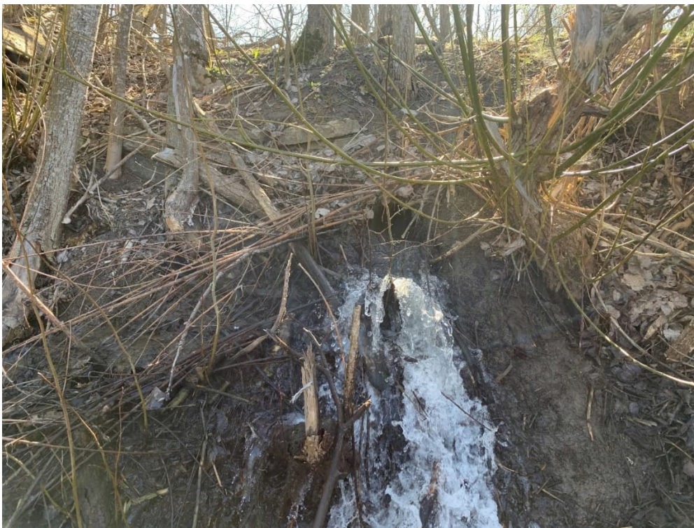
Foto 7 – Anm. 4 Piping och läckage genom fyllningsdammen.
