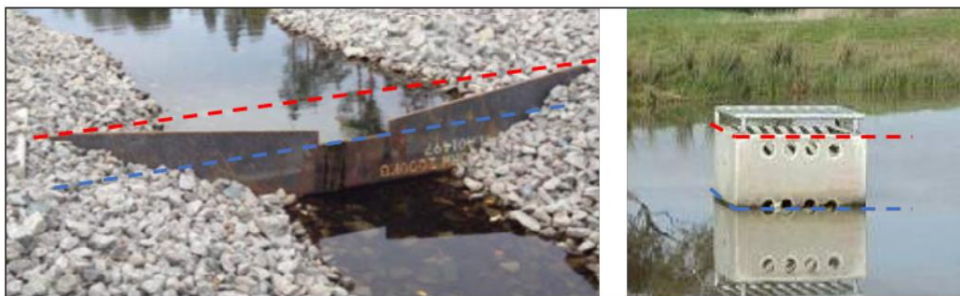
Figur 7. Exempel på olika utloppskonstruktioner. Blå linje: permanent vattennivå, röd linje: reglerhöjd (Svenskt Vatten, 2019)
