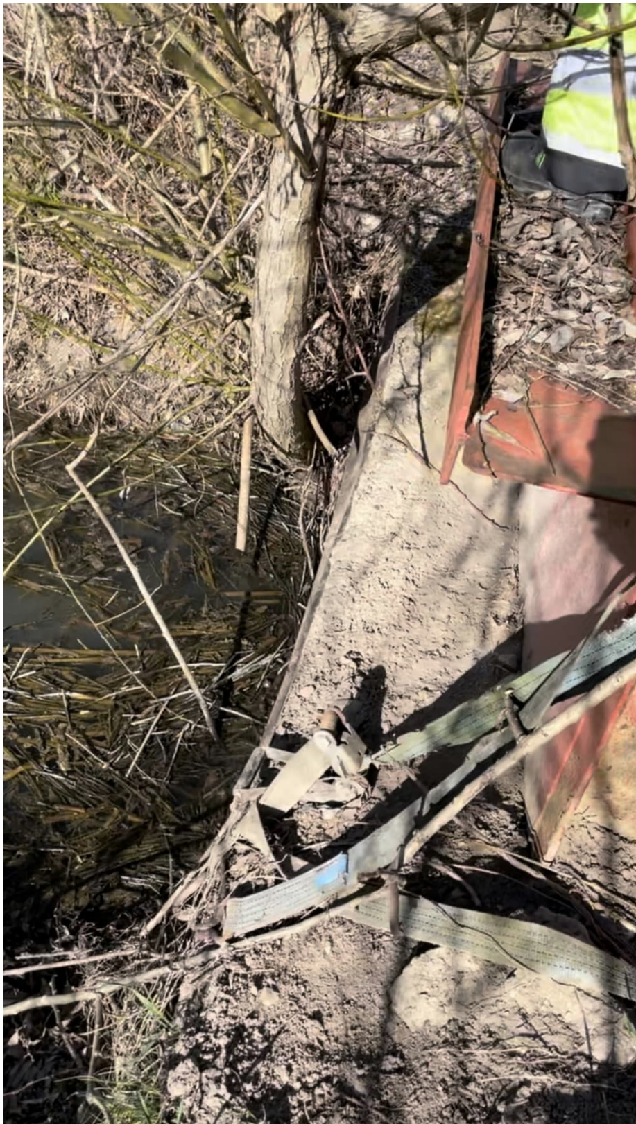
Foto 3 – Anm. 2 Lucka och luckram igensatt av slam
