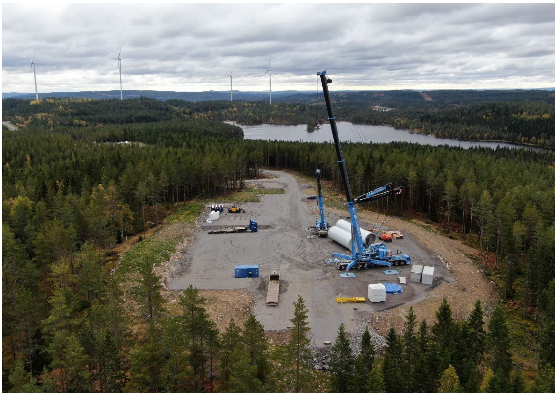
Figur 16. Arbetsytor i vindkraftsparken Norra Länsmansberget i Sunne kommun. Fundament är klart och montering av torn ska påbörjas. För de nedre delarna av tornet används en mindre kran, den som syns på bild. Sedan används en större kran för montering av de resterande torndelarna, maskinhuset, rotn och rotorbladen. Foto av Jonathan Hjorth.
