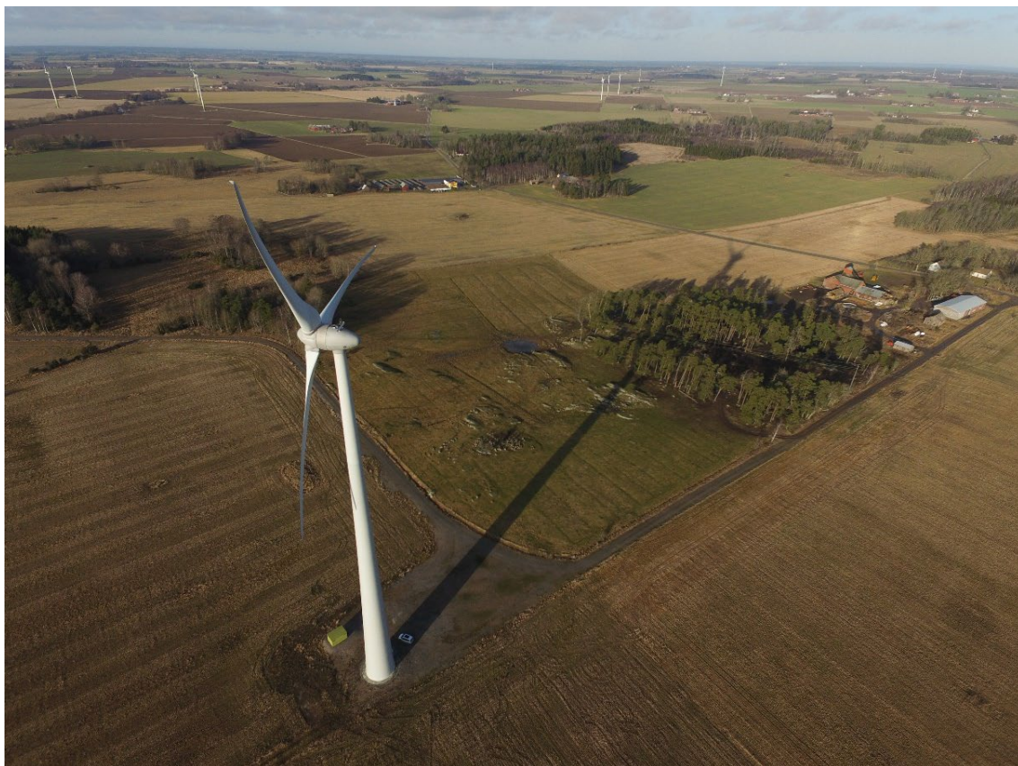
Figur 21. Exempel på skuggning i Tagelberg vindkraftspark i Skara kommun. Fotot är taget i januari cirka kl. 14 då solen står lågt och skuggorna blir långa. Foto av Jonathan Hjorth.
