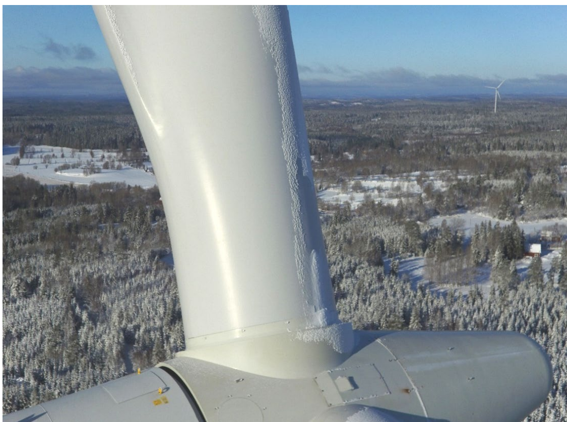
Figur 28. Exempel på ispåbyggnad på vindkraftverk i Fredriksdal vindkraftspark i Nässjö kommun. Foto av Jonathan Hjorth.
