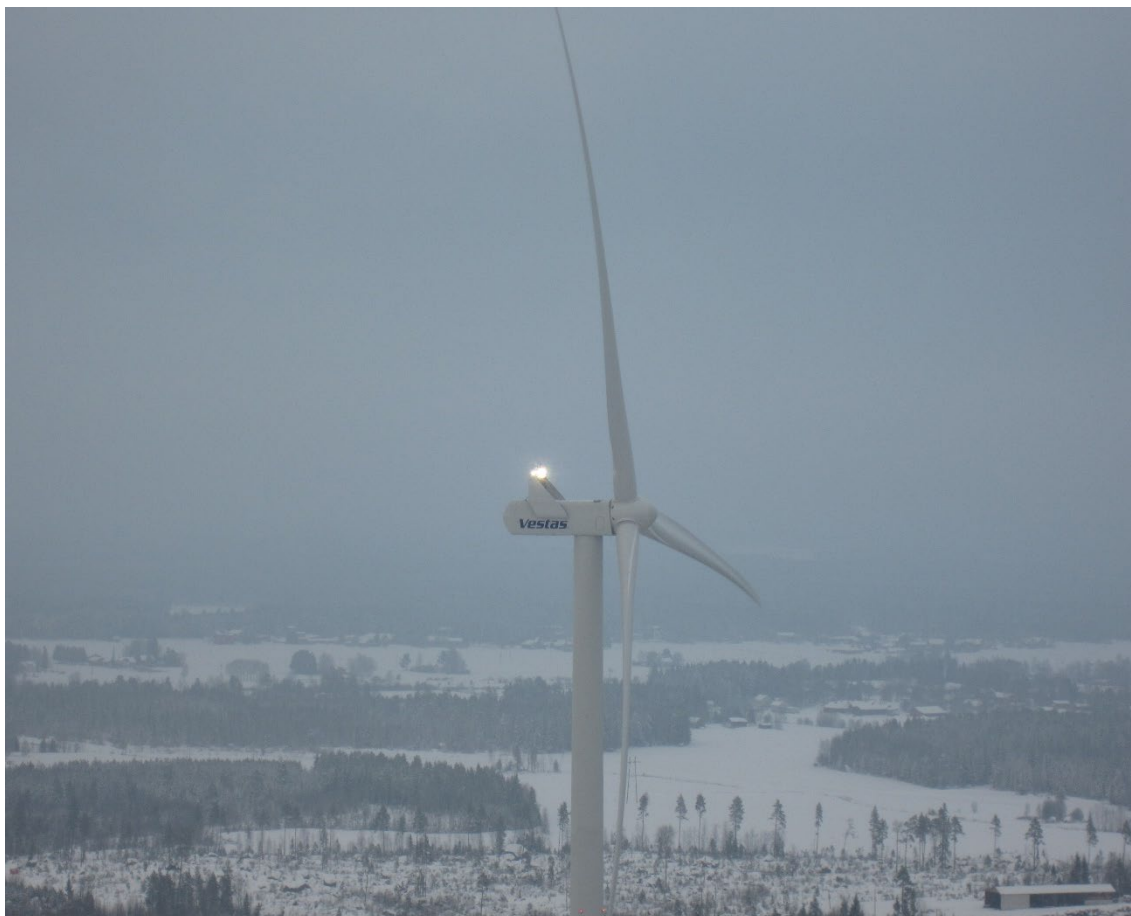
Figur 25. Hinderljus på ett Vestas V126 i en vindkraftspark i närheten av Vähäkyrö i Finland. Foto av Cajsa Abrahamsson.
