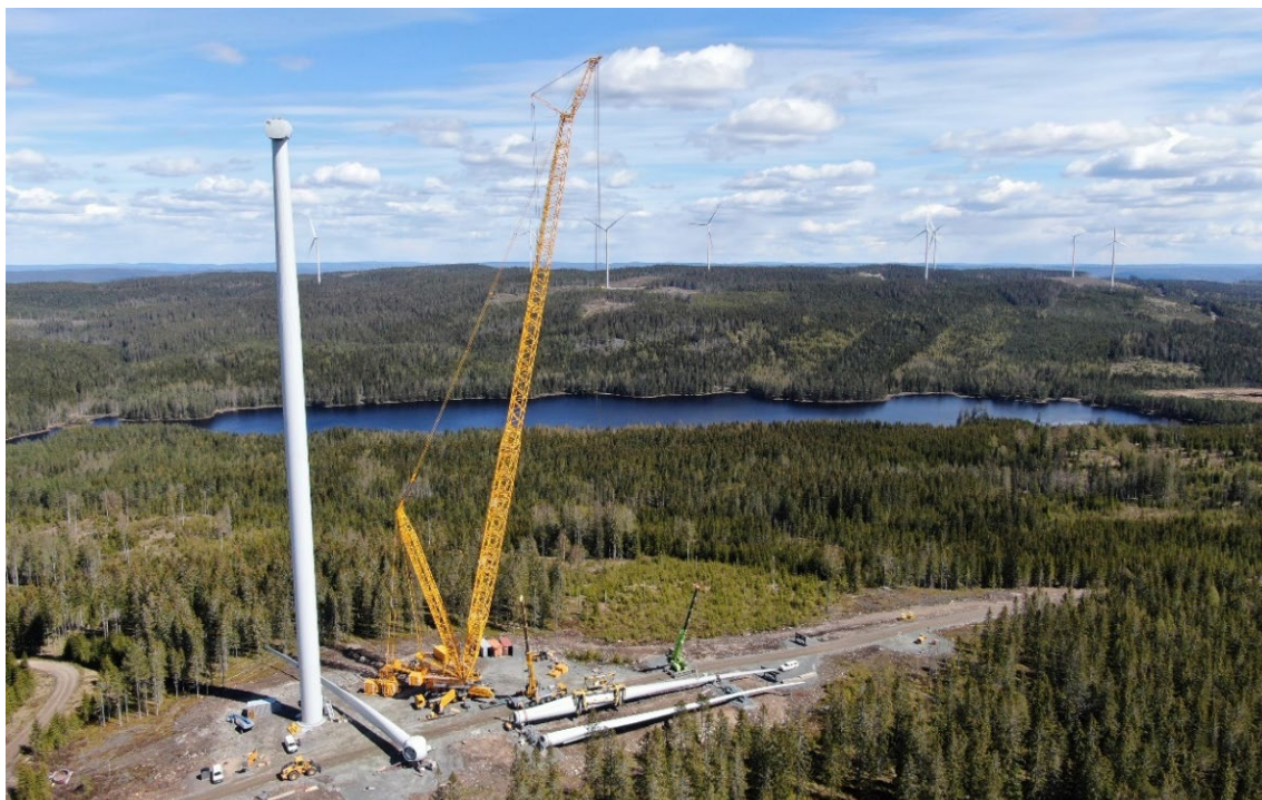
Figur 17. Byggnation av ett vindkraftverk i vindkraftsparken Norra Länsmansberget. Montering av rotorblad är på gång. Foto av Jonathan Hjorth.
