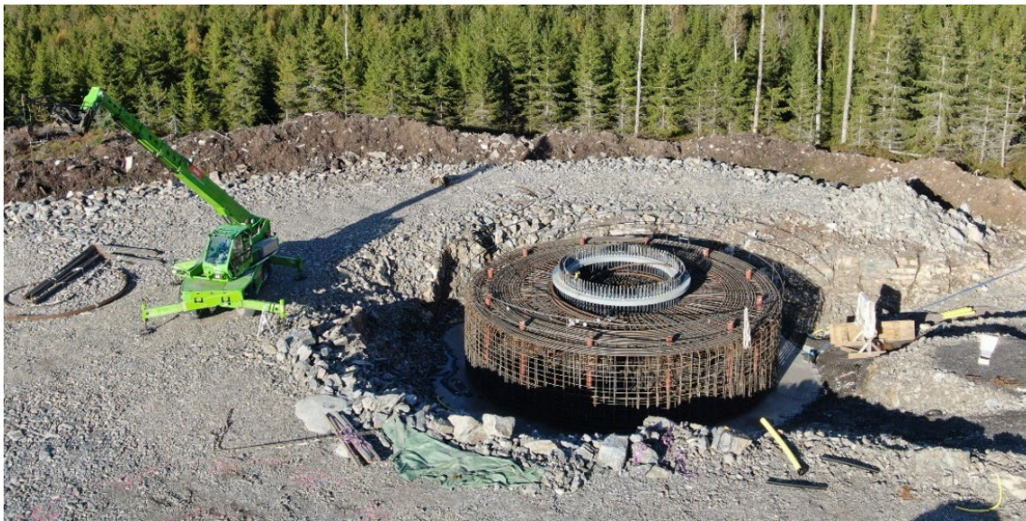
Figur 9. Ett bergsförankrat fundament under byggnation av vindkraftspark Norra Länsmansberget i Sunne kommun. I nästa skede ska fundamentet fyllas med cement. Foto av Jonathan Hjorth.
