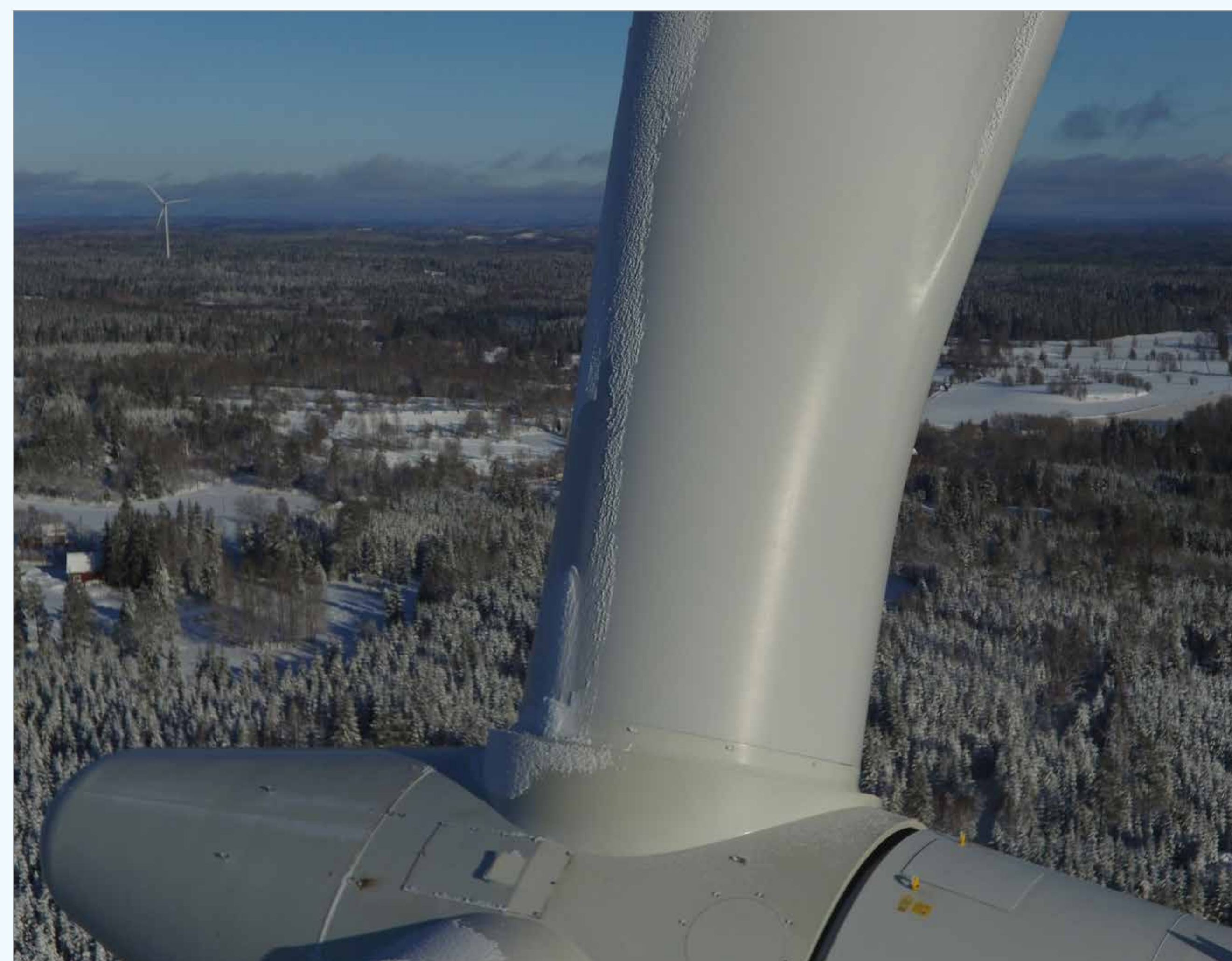
Isbildning på vindkraftverk
