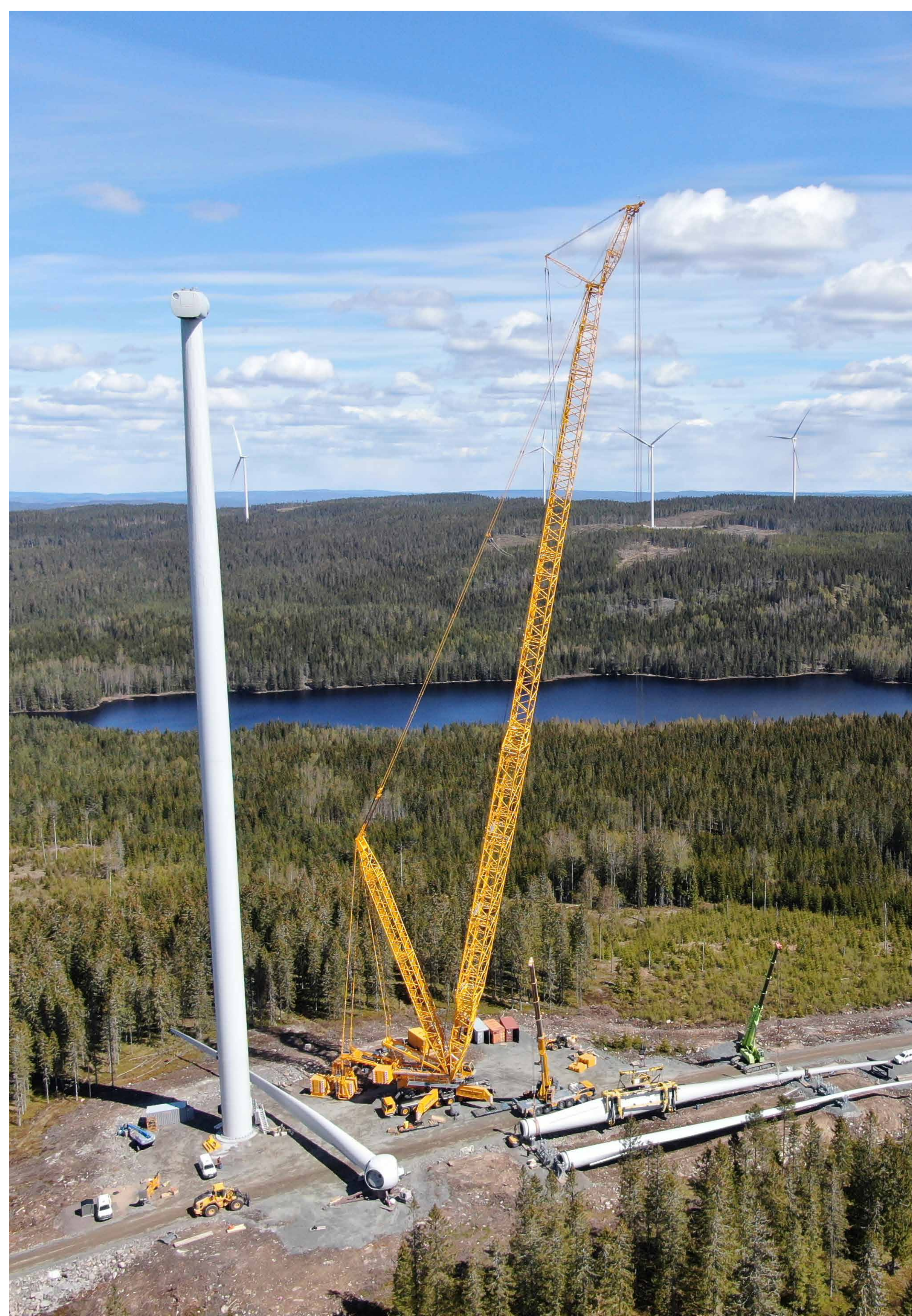
Montering av vindkraftverkets blad
