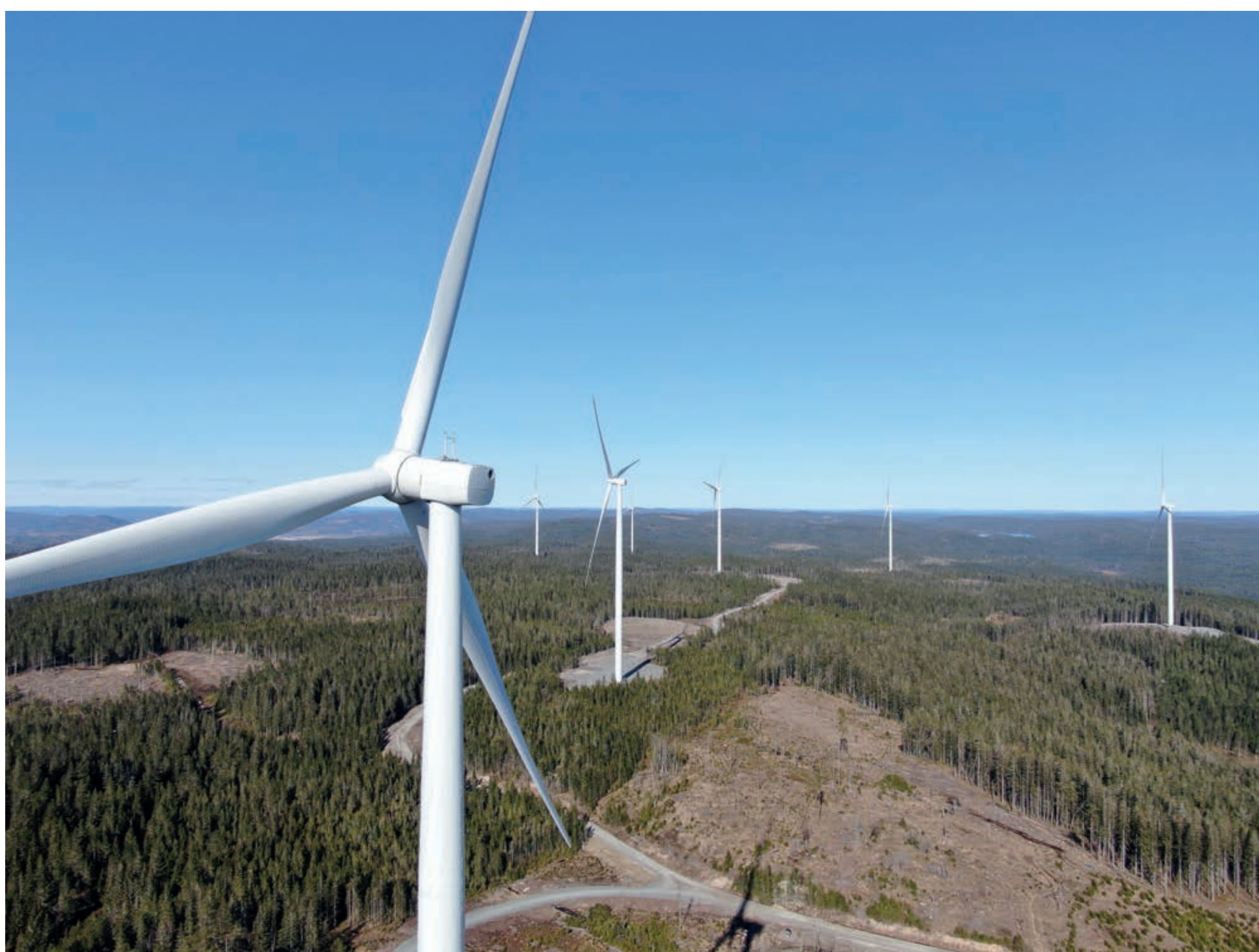
För vindkraftsparken Hälsberget och södra Länsmansberget i Värmland har Tekniska verken gett bygdepeng till bland annat renovering av en hembygds-gård, handikappanpassning av en fiskebrygga och byggande av vindskydd för allmänheten.
