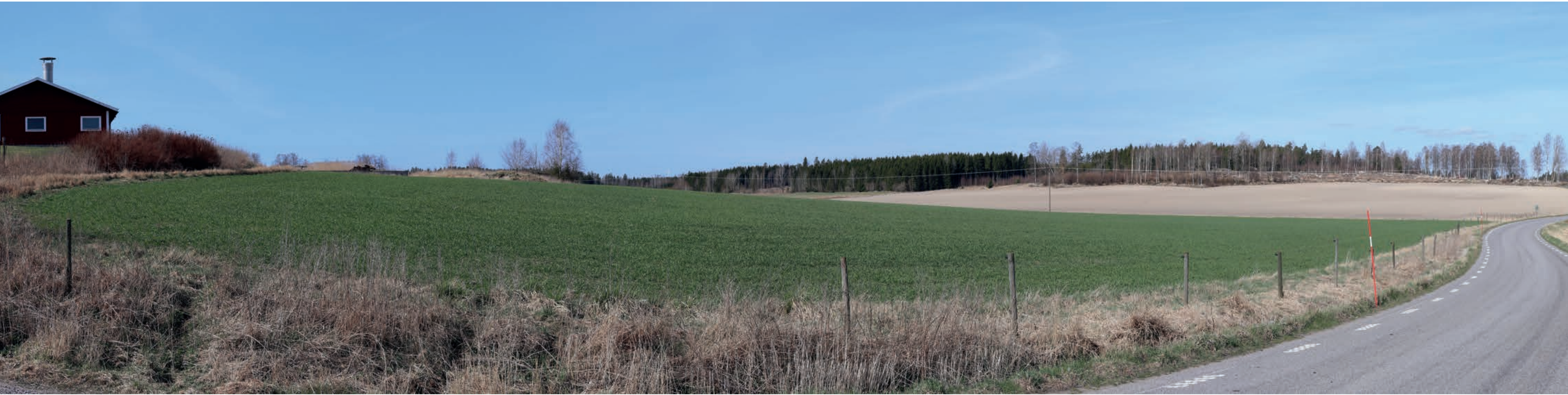
Fotomontage vid Bjärsätter. Fotot är tagen längst med väg 534. Vindkraftverken ligger på ett avstånd om cirka 6,9km från projektområdet. Majoriteten av vindkraftverken döljs av vegetation och terräng.
