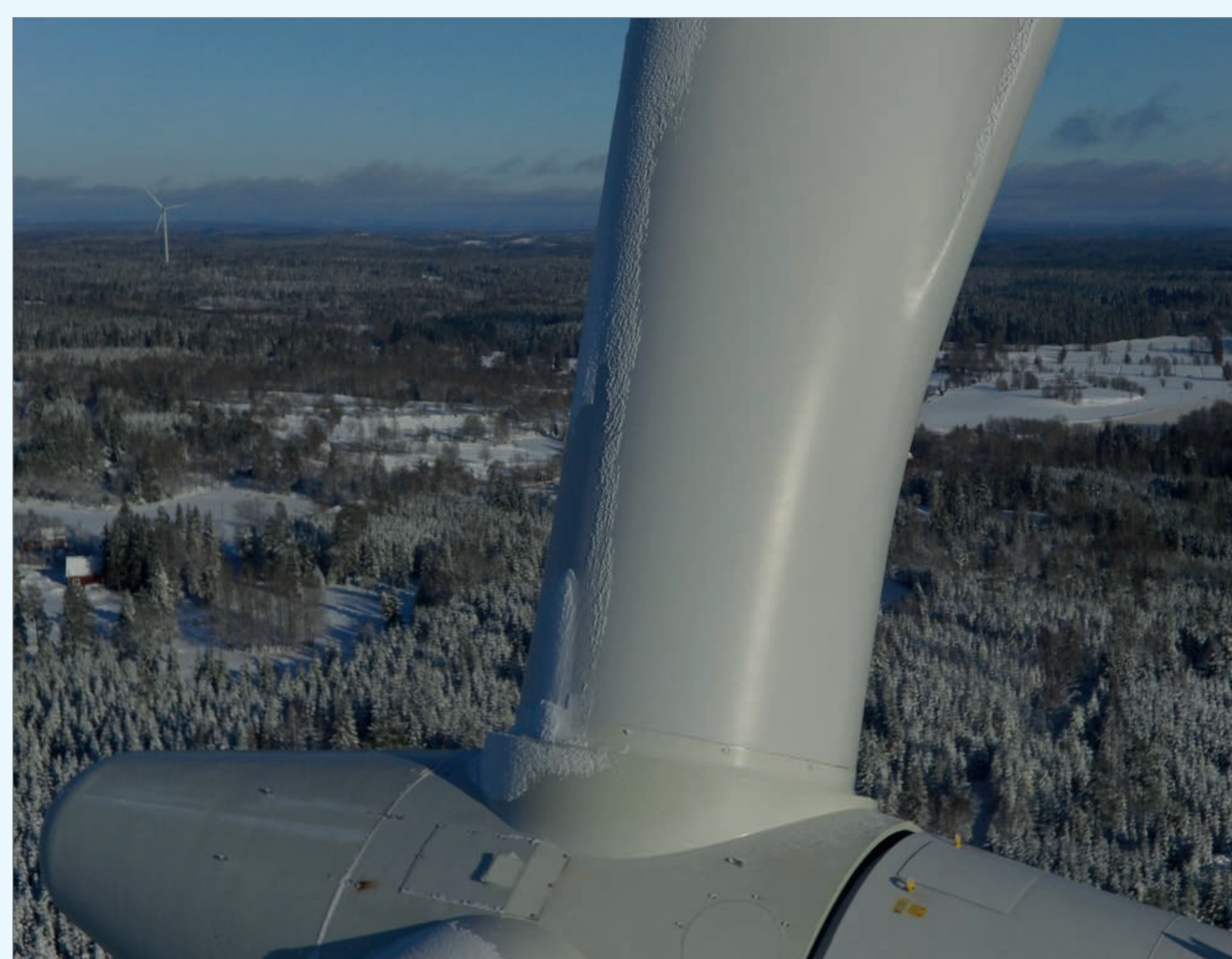
Isbildning på vindkraftverk
