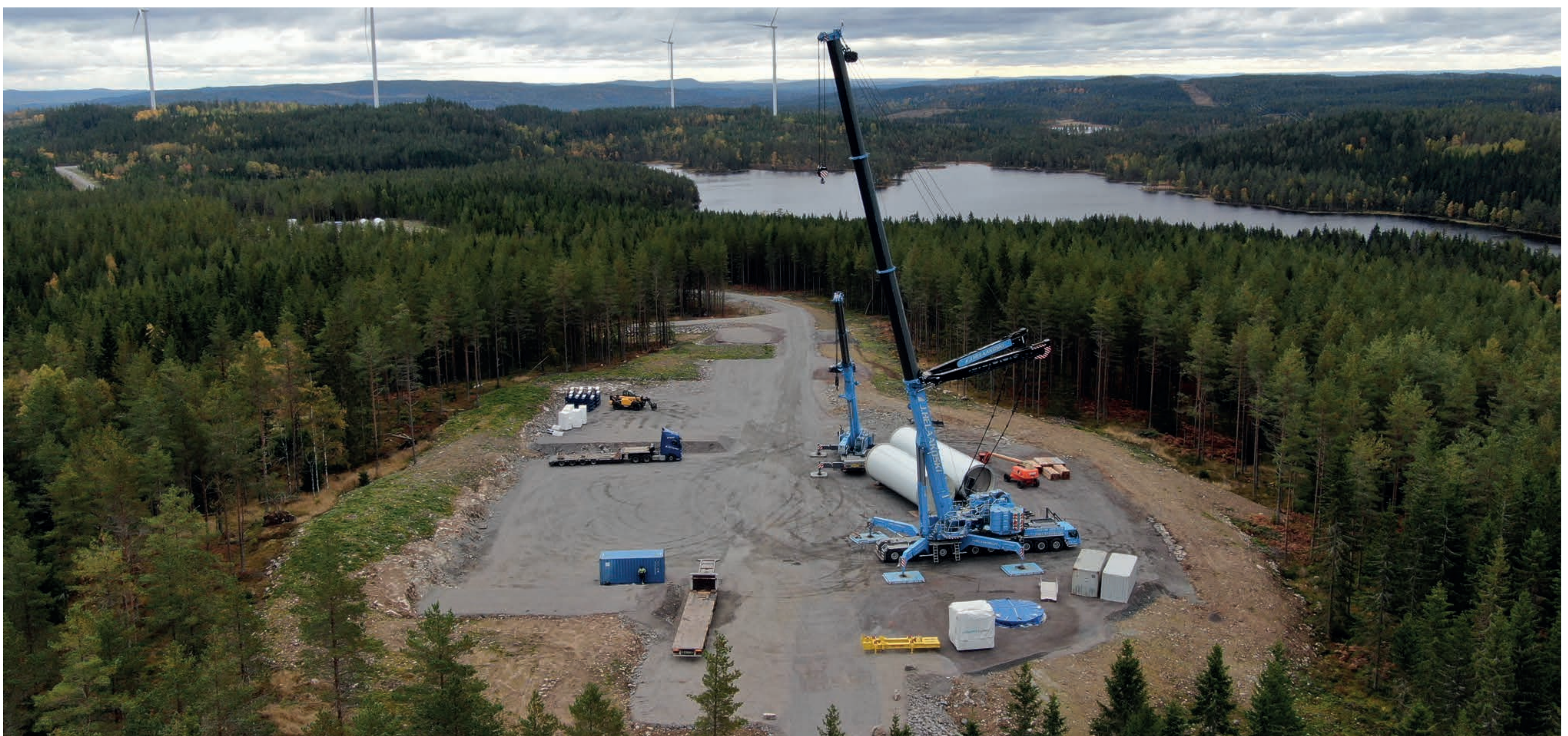
Arbets- och upplagsytor vid ett vindkraftverk
