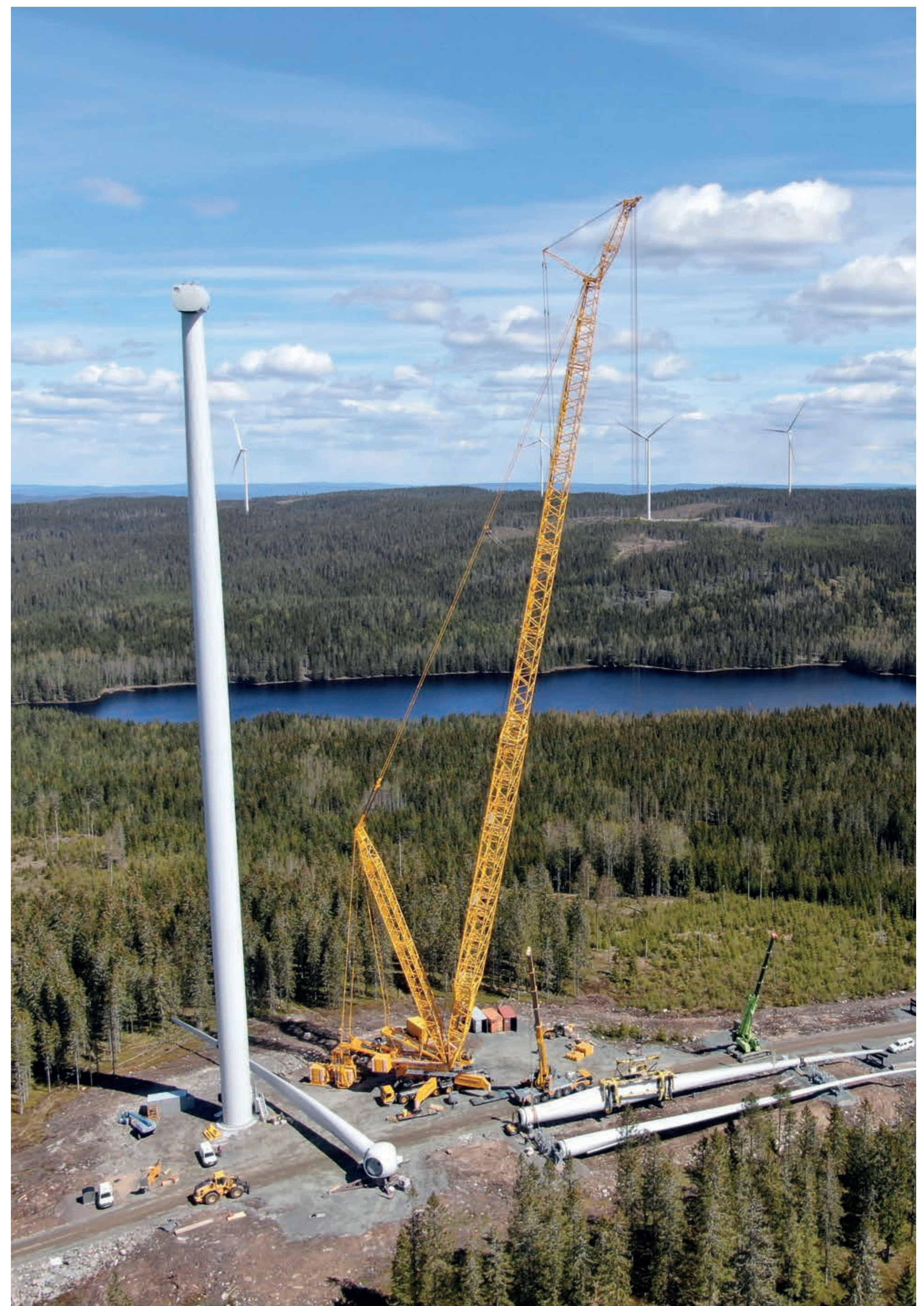
Montering av vindkraftverkets blad
