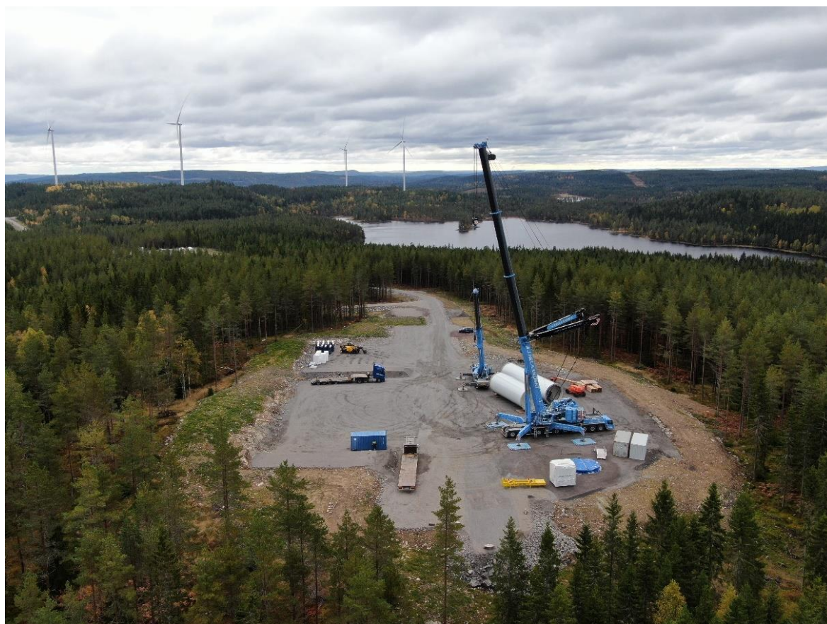
Figur 16. Arbetsytor i vindpark Norra Länsmansberget i Sunne kommun. Fundament är klart och montering av torn ska påbörjas. För de nedre delarna av tornet används en mindre kran, den som syns på bild. Sedan används en större kran för montering av de resterande torndelarna, maskinhuset, rotorn och rotorbladen. Foto: Jonathan Hjorth.
