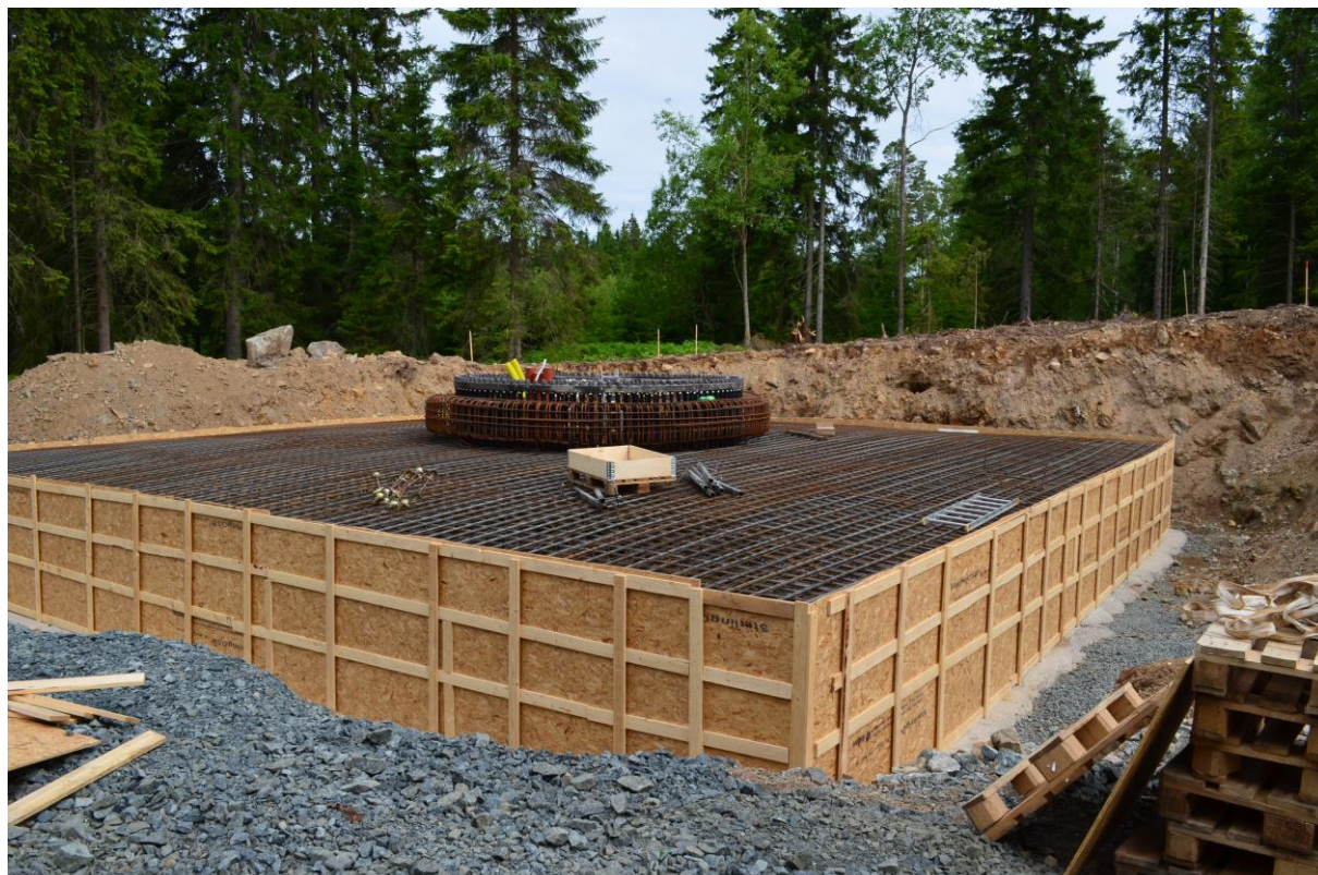
Figur 14. Ett gravitationsfundament under byggnation av Fredriksdals vindkraftpark i Nässjö kommun. På bilden syns armeringsjärn, när armeringen är på plats och kontrollerad kan betongen gjutas inuti schakten för att skapa fundamentet. Foto: Jonathan Hjort.
