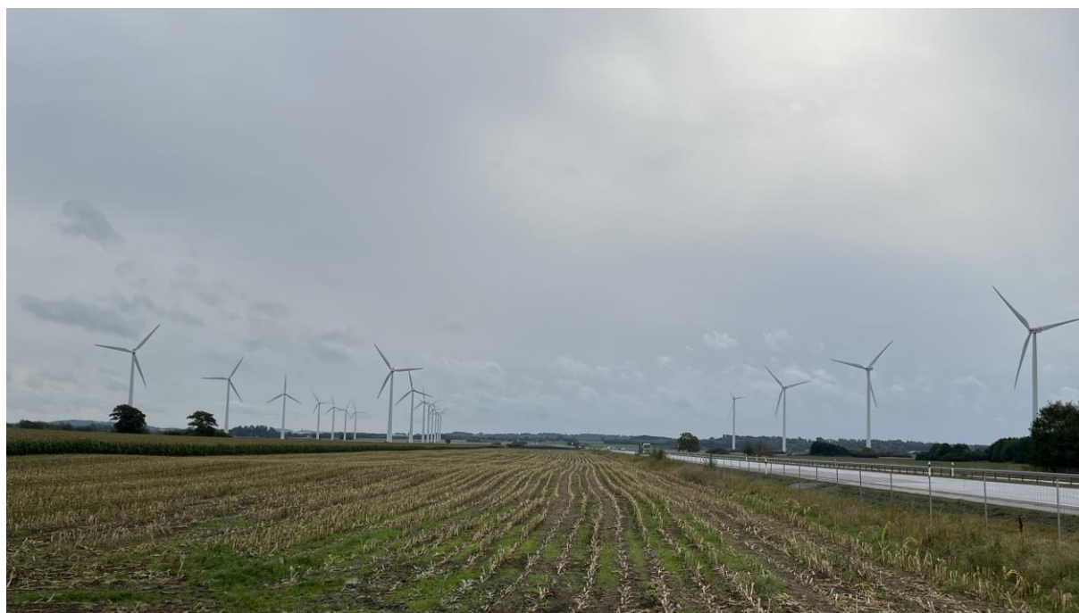
Figur 8. Befintliga vindkraftverk. Bilden är tagen med vy mot söder. Till höger i bild syns fyra vindkraftverk i Torebo vindkraftspark som inte är föremål för generationsväxling.
