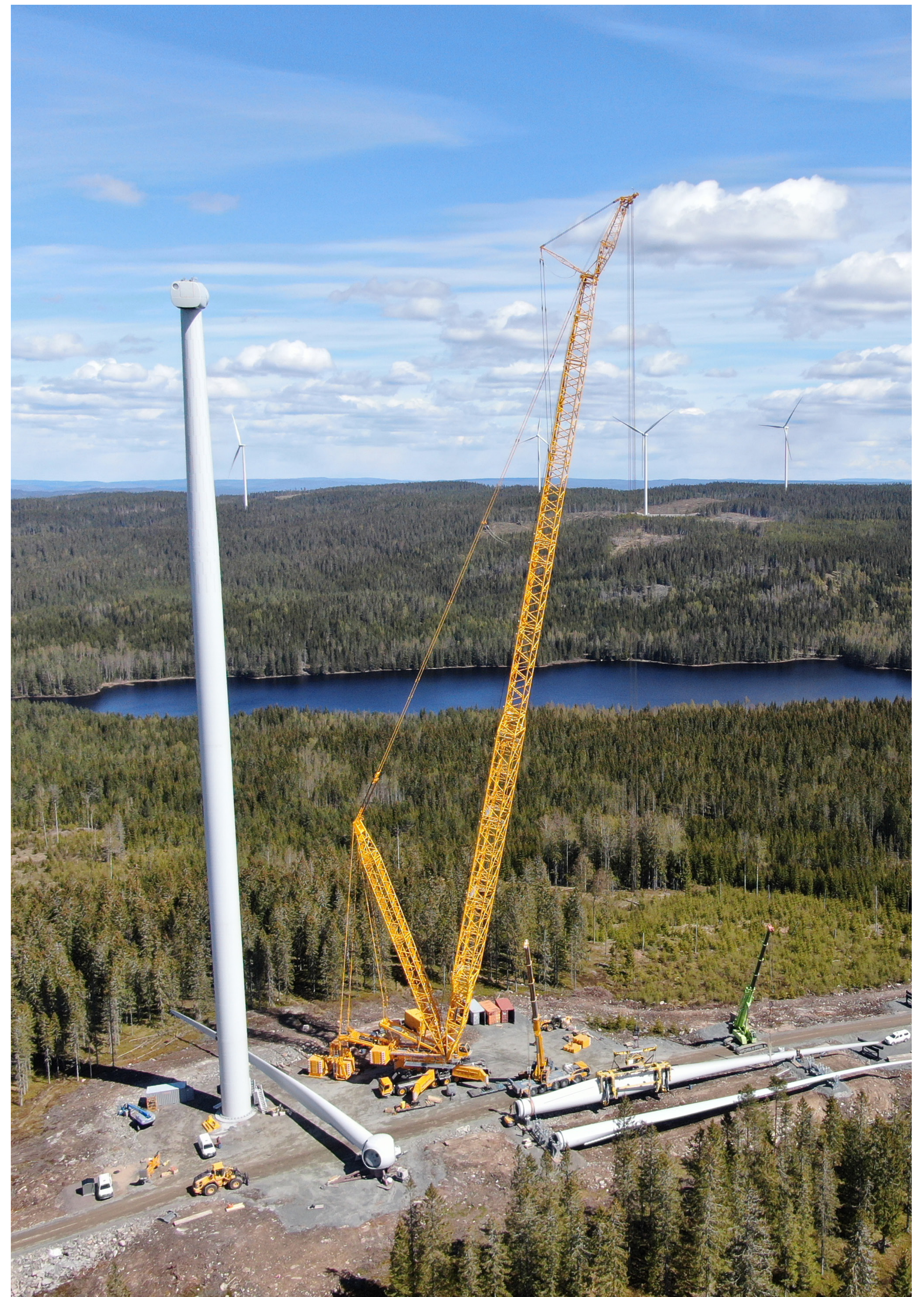
Montering av vindkraftverkets blad
