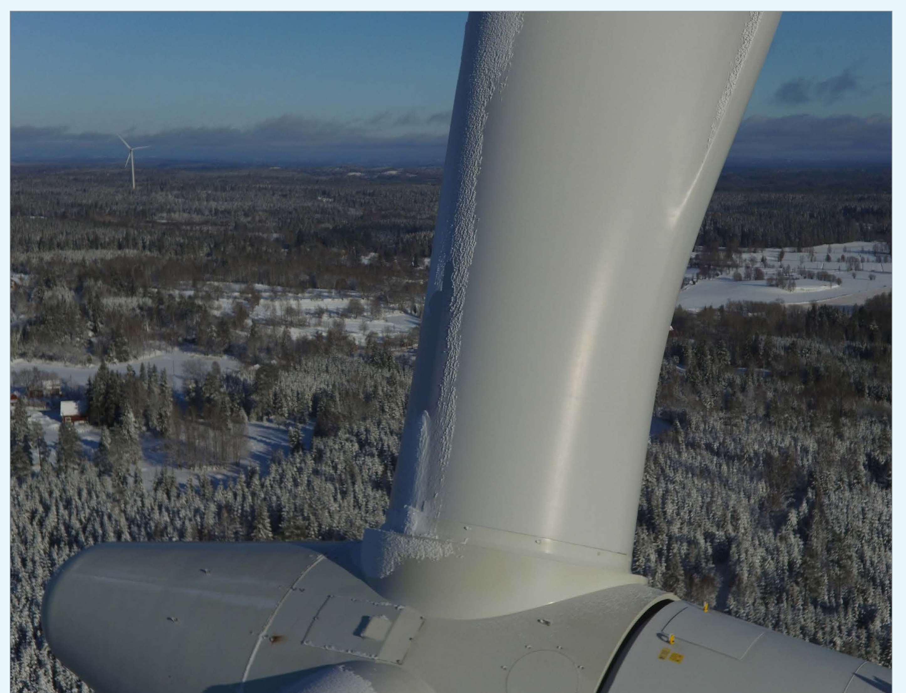
Isbildning på vindkraftverk
