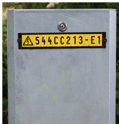
Styrcentraler märks i samma nummerserie som stolpar.
