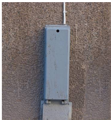
2. Utanpåliggande säkringscentral, GAROs sk "Göteborgsdosa" i gjuten silumin.
