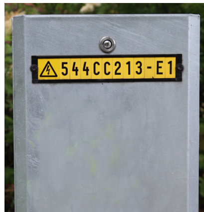
Styrcentraler märks i samma nummerserie som stolpar.
