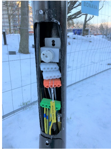
Närbild på nedre lucka (ovan) med stolp-central och övre lucka(till höger) med Wifi utrustning.
