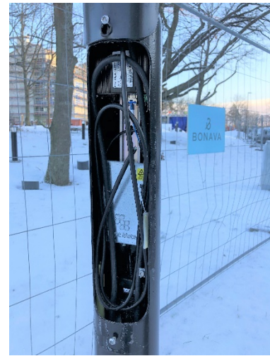
Närbild på nedre lucka (ovan) med stolp-central och övre lucka(till höger) med Wifi utrustning.
